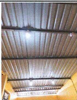
Foto1: Se instaló lámina troquelada en la cocina.
