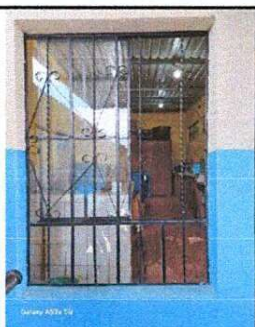
Foto 5: Se instaló ventana tipo balcón corrediza para ventilación en la cocina.
