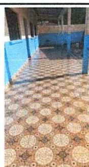
Foto 6: Se instaló piso cerámico antideslizante.
