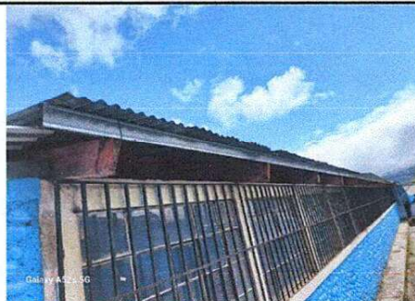
Foto 8: Se observa el cambio de la viga de madera por costanera de metal de 3"x 2".
