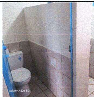
Foto 9: Se instaló dos baños en el servicio de baño de docentes.
