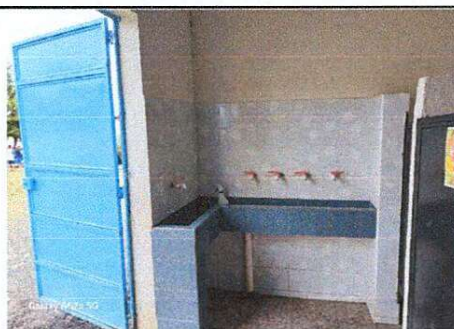
Foto 11: Se cambió de dirección a la puerta, se pintó de azul y se instaló lavamanos de concreto y azulejo.
