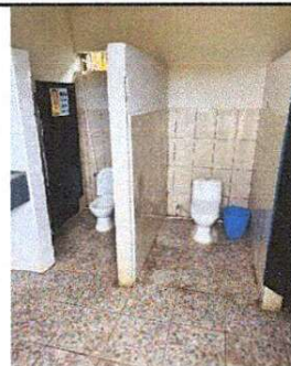
Foto 10: Se instalaron dos baños pequeños exclusivo para estudiantes de preprimaria.
