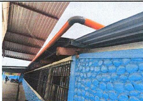
Foto 7: Se instaló canal de PVC y bajada pluvial.
