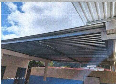
Foto 3: Se instaló estructura de metal y lámina troquelada frente a la cocina.
